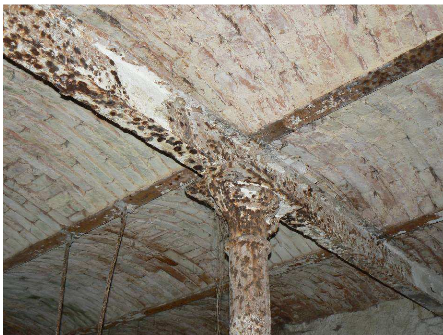
Obr. 10. Detail litinových prvků stropu před očištěním (2008).
