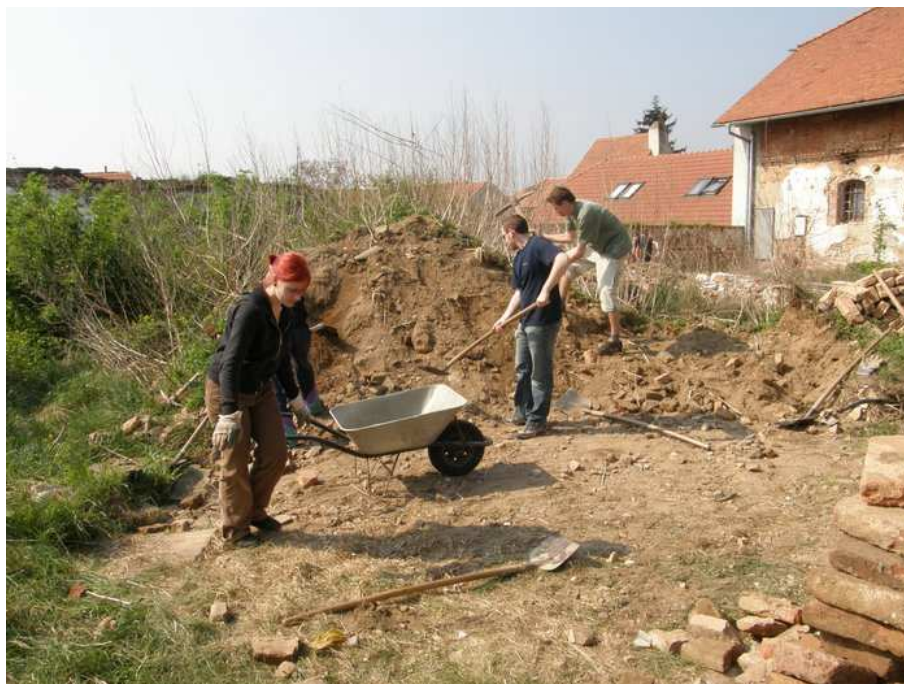
Obr. 12. Úprava okolí bývalé stáje – rozvážení stavební sutě a vyrovnávání terénu (2009).
