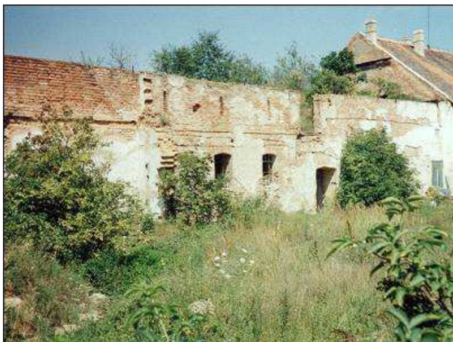
Obr. 1. Stav budovy bývalé stáje v roce 2003 před zahájením rekonstrukce.
