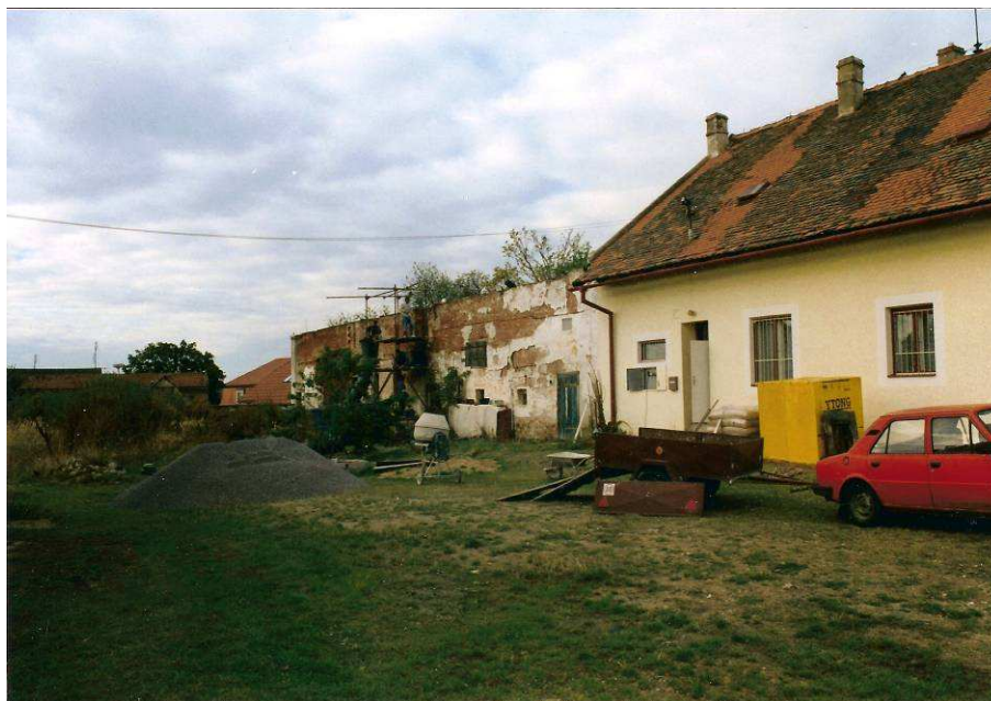
Obr. 3. Budoucí muzeum po zahájení rekonstrukce (2003).
