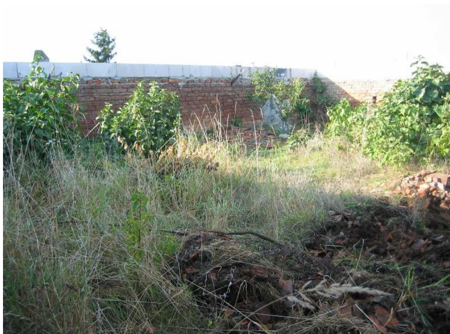
Obr. 5. Strop bývalé stáje v roce 2005 po obezdění věncem tvárníc (patrný v pozadí).
