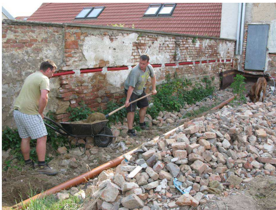
Obr. 11. Budování kanalizační přípojky pro restaurátorskou pracovnu a budoucí muzeum (2009).
