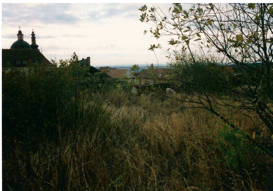
Obr. 2. Pohled ze stropu bývalé stáje před začátkem rekonstrukce (2003).
