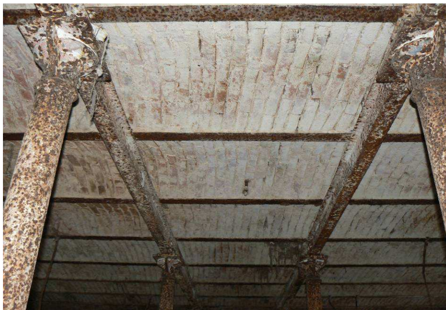
Obr. 9. Klenba stropu a litinová nosná konstrukce před očištěním (2008).
