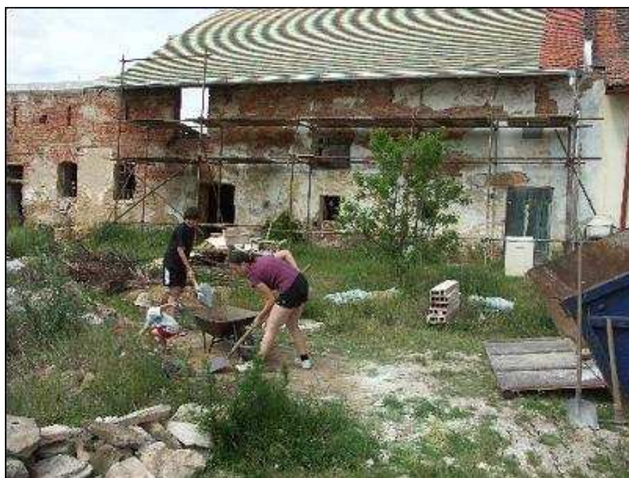
Obr. 6. Práce při budování nové střechy v roce 2005.
