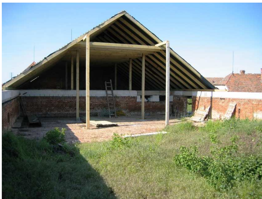
Obr. 7. Tesařské práce na střeše budovy (2005).
